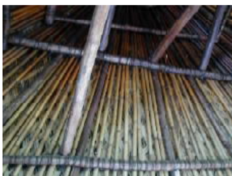
写真3-14 集会棟の天井の様子
