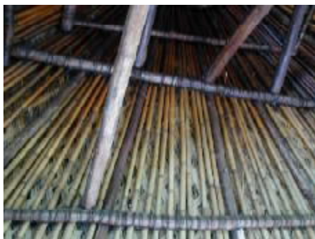
写真3-14 集会棟の天井の様子
