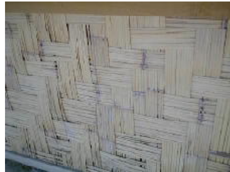
写真3-4 竹で編んだ外壁
