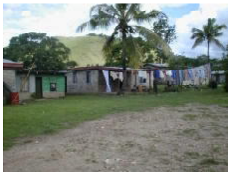
写真3-16・3-17 村の定住用の住居（屋根はトタン、壁はブロック、窓にはガラス）
