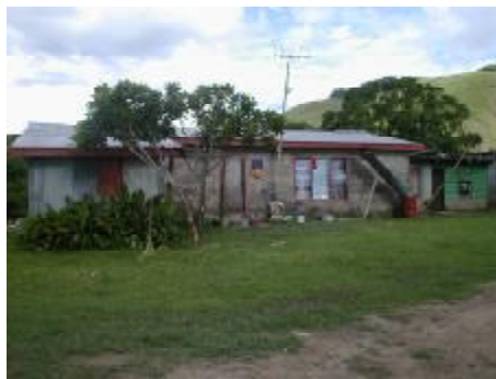
写真3-16・3-17 村の定住用の住居（屋根はトタン、壁はブロック、窓にはガラス）
