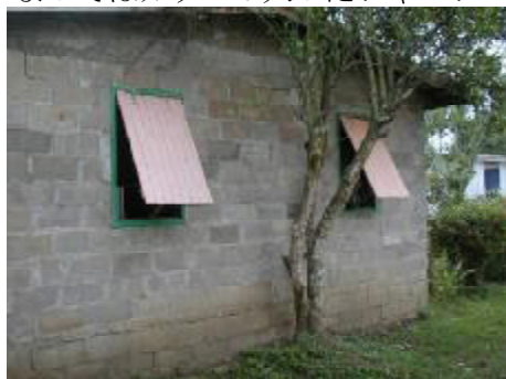
写真3-20 突き出し窓
