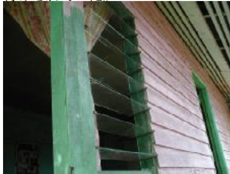
写真3-21 ジャロジー窓
